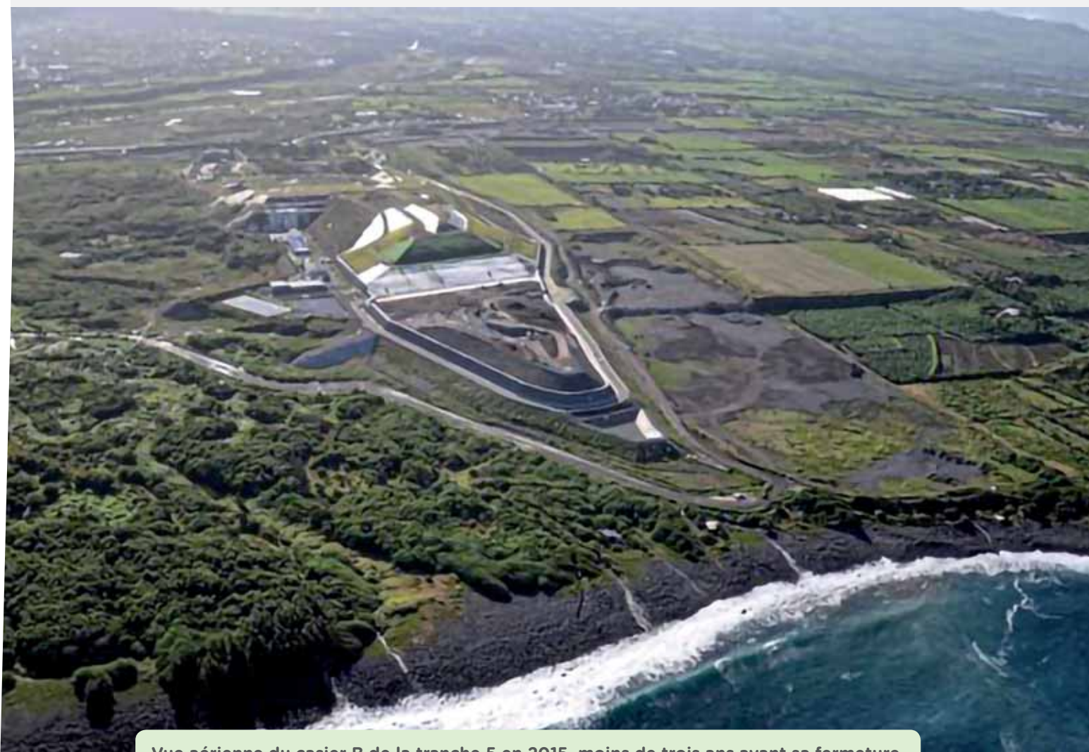
Vue aérienne du casier B de la tranche 5 en 2015, moins de trois ans avant sa fermeture.
