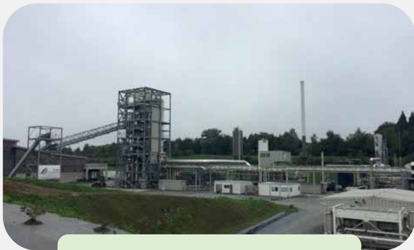
Chaudière CSR de Changé (53)
